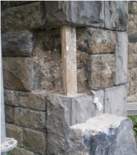
Ein stark gerissener Eckstein wurde von der ausführenden Firma Meyer Restaurierungen aus Preußisch Oldendorf ausgebaut. So konnte ein Blick in das Innere des Strebepfeilers geworfen werden. Übermäßiger Wasserbruch ließ sich so ausschließen.
